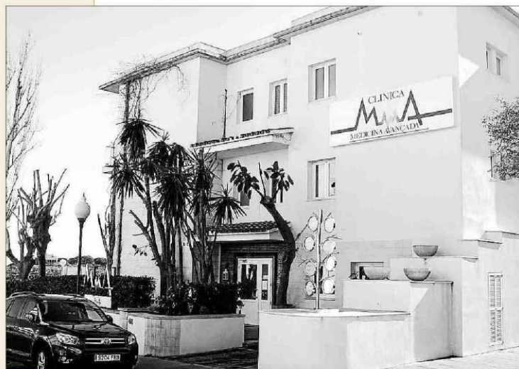
El Centre de Medicina Avançada de Maó, recientemente integrado en la Clínica Menorca.
