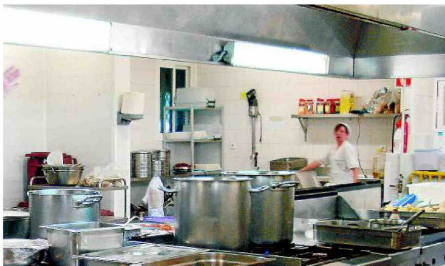
Les cuines de l'hospital Psiquiàtric, des d'on es fan menús per a la concessionària.
