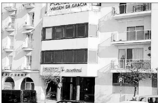
Las instalaciones sanitarias están situadas en la avenida Vives Lluïl de Maó.
