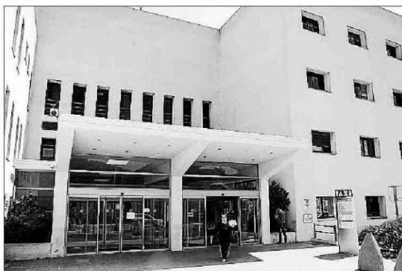
La entrada del hospital de Can Misses.
