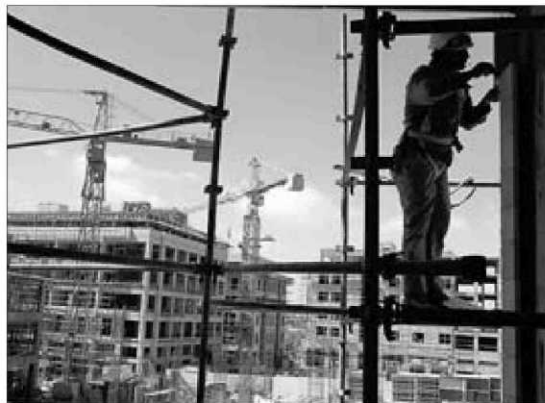
Un operario de la construcción trabaja sobre un andamio. REUTERS
