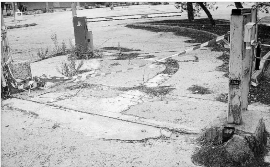
Aspecto que presenta la entrada del aparcamiento delante de la puerta principal del Hospital.
