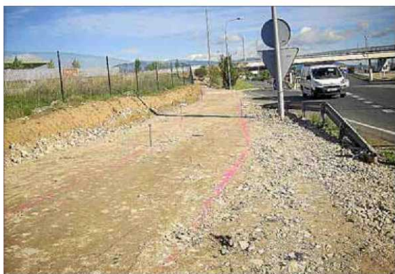
Las obras comenzaron el lunes y se prolongarán durante varios días.
