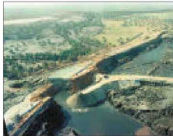
Balsa de Boliden en Aznalcóllar.
