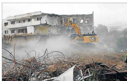
El derribo y desescombro del solar durará varios días. VICENT MARÍ
