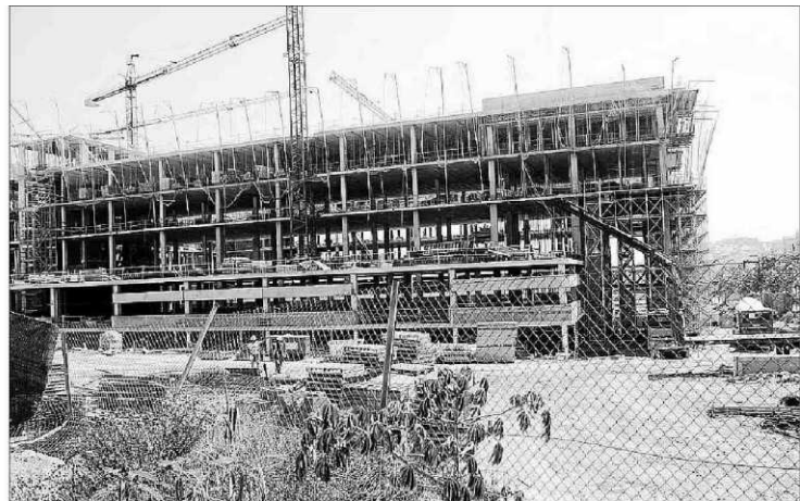
Imagen de la ampliación del hospital de Can Misses.
