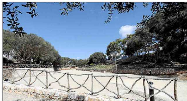
Finalizan las obras de acondicionamiento en la zona. LOCAL • Pág. 8
