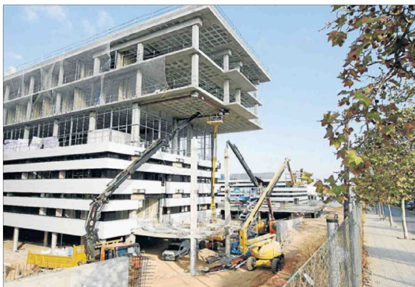
Los trabajadores comenzaron ayer a retirar las columnas que sustentaban la planta. VICENT MARI
