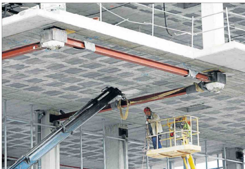
Una grúa y un operario, ayer, durante los trabajos. VICENT MARI
