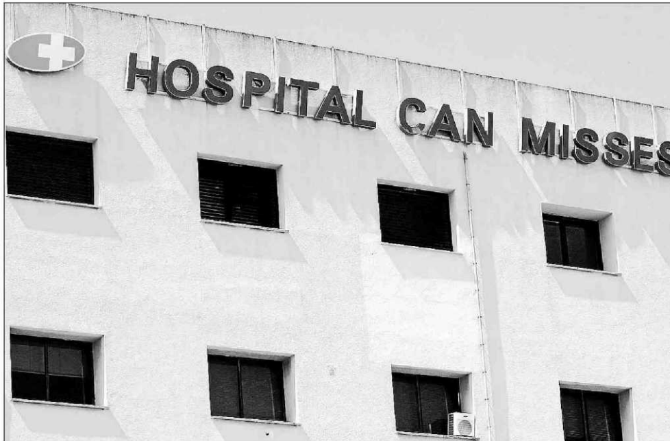
Imagen de la fachada del hospital de Can Misses de Eivissa.
