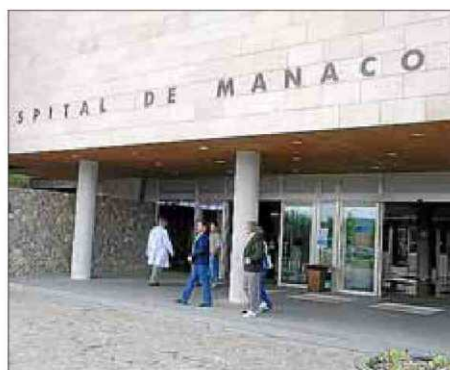
Fachada del hospital comarcal de Manacor.
