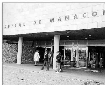
Fachada del hospital comarcal de Manacor.
