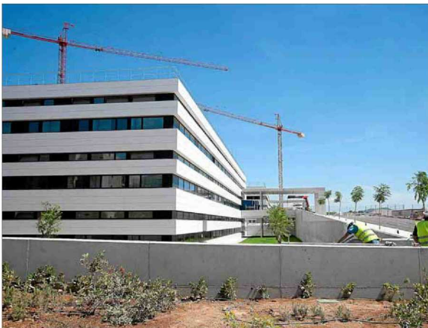
Estado actual en el que se encuentran las obras del nuevo hospital de Can Misses. / SERGIO G. CAÑIZARES
