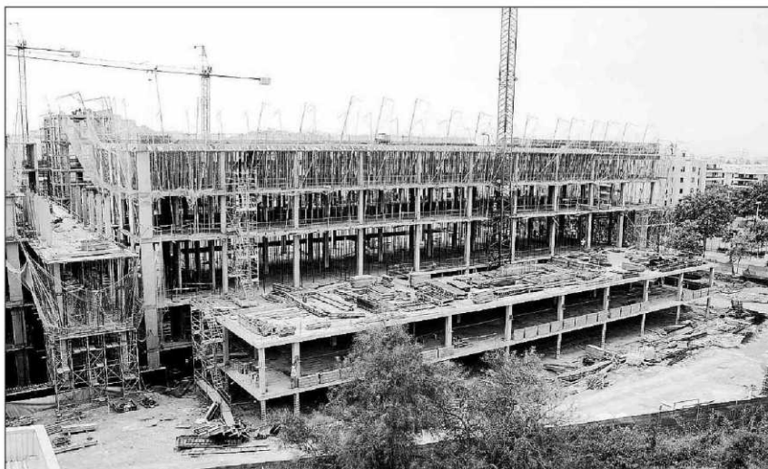
Las obras del nuevo hospital de Eivissa se encontraban en este estado en el día de ayer. ■ Foto: M. TORRES
