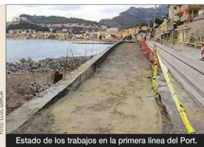
Estado de los trabajos en la primera línea del Port.
